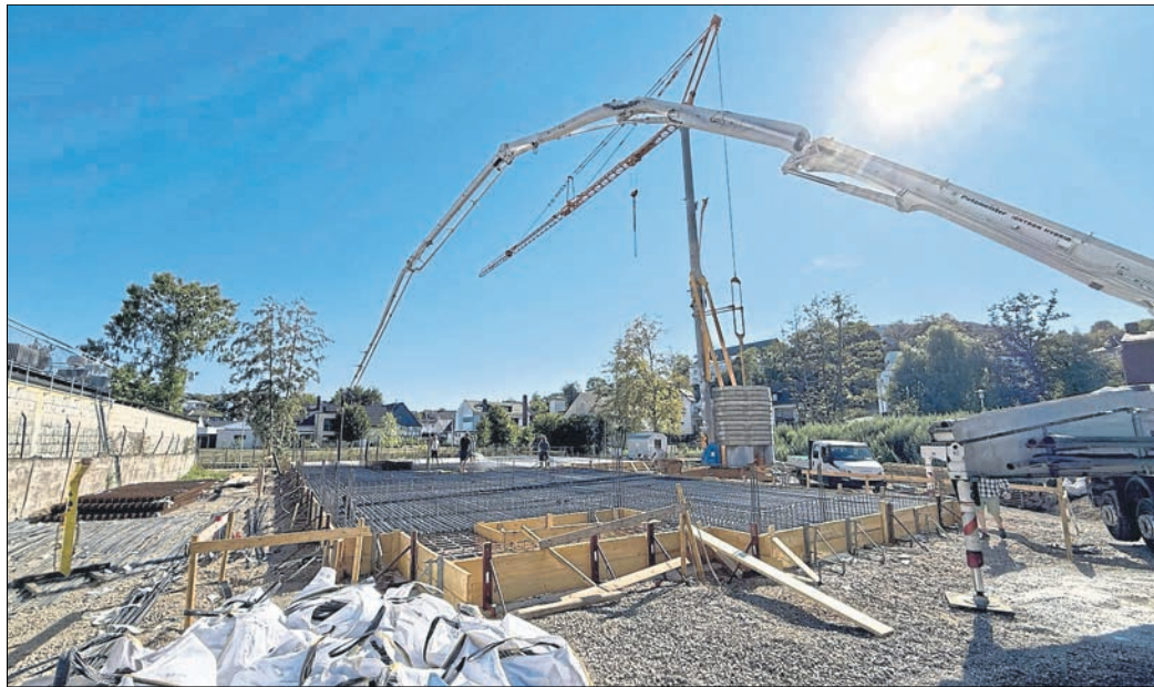
Das Fundament für das BIG BEN Hotel in Nastätten steht. Bereits im August wurde die Bodenplatte betoniert. Foto: BIG BEN Immobilien GmbH
