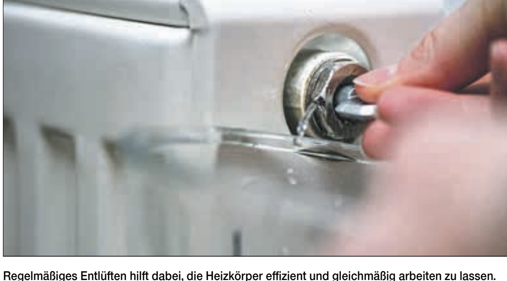
Regelmäßiges Entlüften hilft dabei, die Heizkörper effizient und gleichmäßig arbeiten zu lassen. Foto: Andrea Warnecke/dpa-mag
