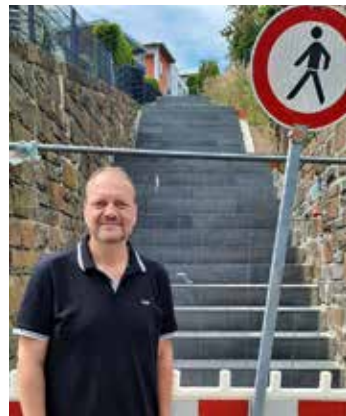
Thorsten Schneider vor Ort bei einer der Treppenbaustellen.
