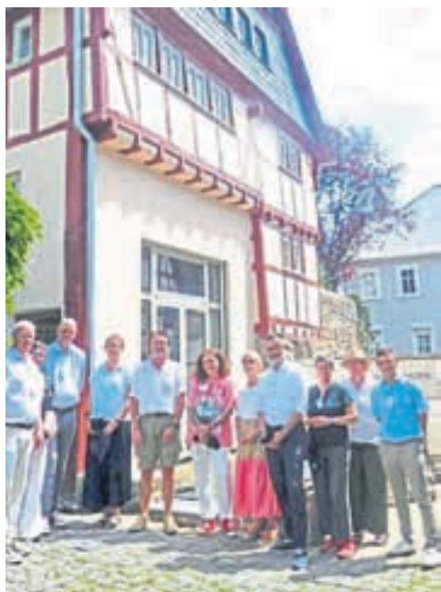
Die Jurymitglieder machten sich zusammen mit Bauherr Klaus Langschied (5. v. links), die sich ein Bild von dem vorbildlich sanierten Fachwerkhaus Roßmarkt 7. Foto: Dieter Fluck
