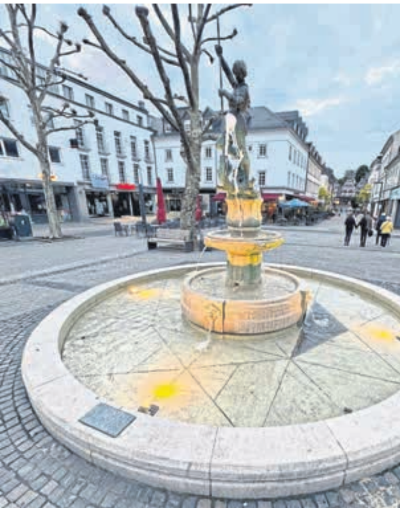
Nach der Sanierung setzt der Georgsbrunnen neue Akzente. Foto: Stadt Limburg
