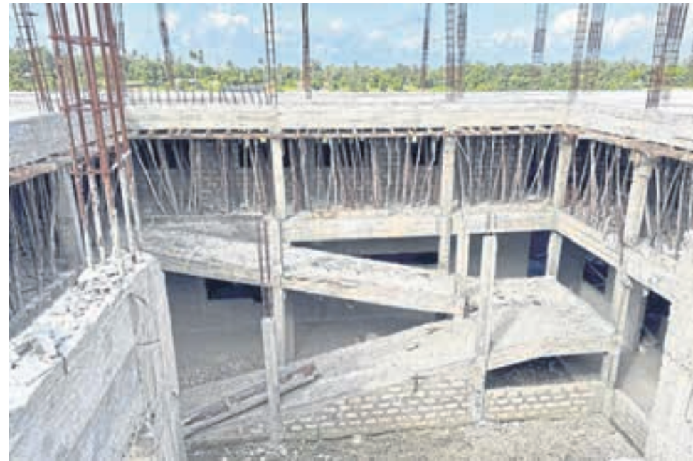
Die Schule im Rohbau: 300 bedürftige Kinder werden dort nach der Fertigstellung unterrichtet. Fotos: Jonathan Schmitt
