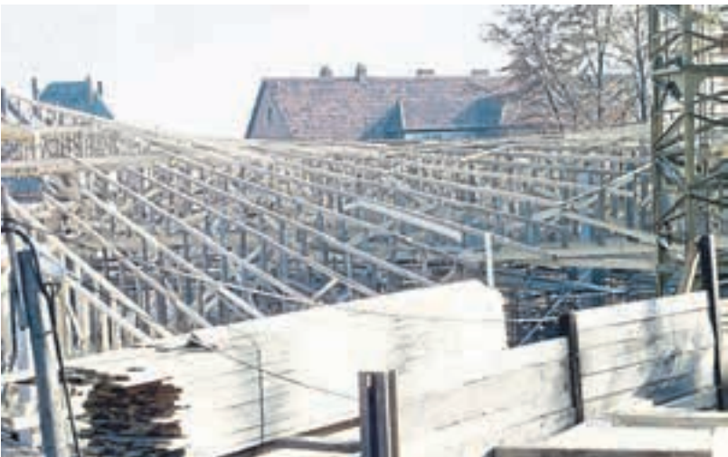
Die Zimmerleute hatten 1966 am Schalentragswerk ganze Arbeit geleistet. Die Dachkonstruktion ist auf nur drei Punkten gelagert. Fotos: Dieter Fluck
