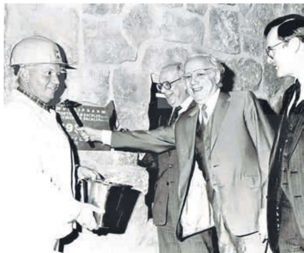
In Anwesenheit von Geschäftsführer Walter Wimmer (rechts) und eines Handwerkers legten Mitte der achtziger Jahre die amerikanischen Mundipharma-Gründer, die Brüder Dr. Raymond und Dr. Mortimer Sackler, den Grundstein für den ersten Erweiterungsbau. Foto: Dieter Fluck
