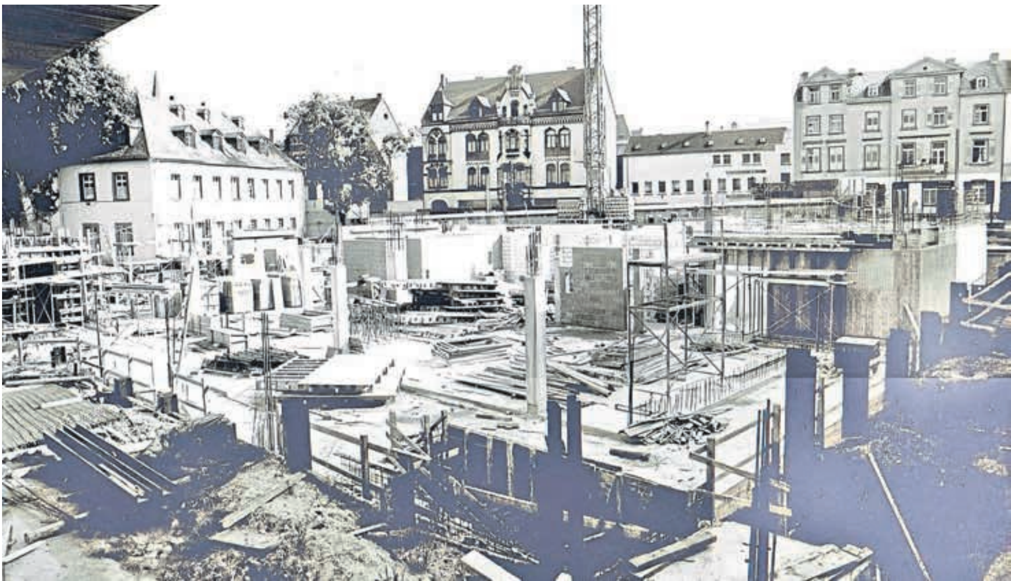
Die Josef-Kohlmaier-Halle erfüllt 50 Jahre nach der Grundsteinlegung und dem Baubeginn als repräsentatives Bauwerk ihre Funktion als kultureller Treffpunkt für die Region. Fotos: Archiv Dieter Fluck
