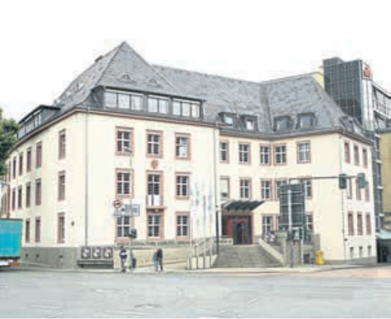
Das Landratsamt in Limburg an der Ecke Schiede/Diezer Straße ist für 176.000 Menschen des Kreises Limburg-Weilburg zuständig. Bei seiner jüngsten Renovierung wurde die Fassade mit einem frischen Anstrich versehen. Im Bild rechts befindet sich die 2002/03 neu errichtete Kreissparkasse. Foto: Dieter Fluck
