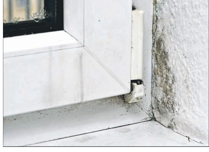
Mit Alkohol, Schutzkleidung und ausreichend Vorsicht können kleinere Schimmelflächen selbst entfernt werden.
