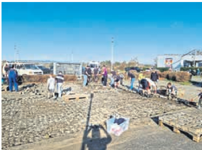
Auf dem Gelände wird fleißig gearbeitet.
