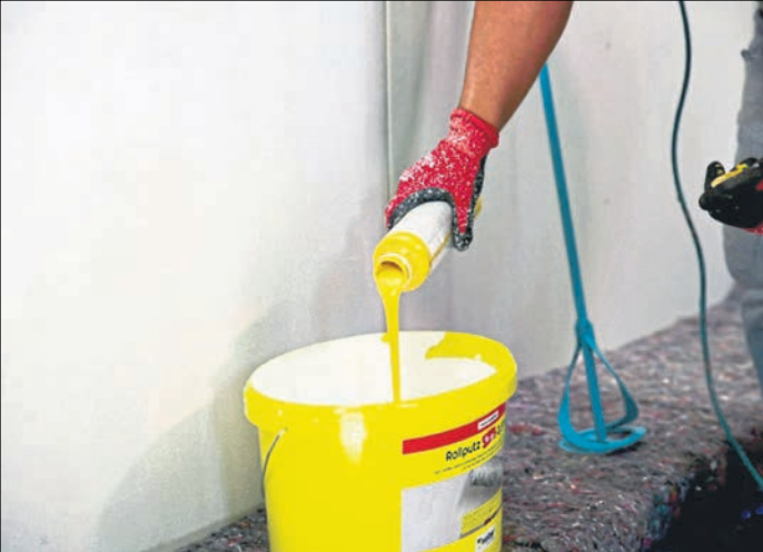
Rollputz lässt sich vor dem Auftragen mit Farbpigmenten abtönen. Foto: txn/SG Weber
