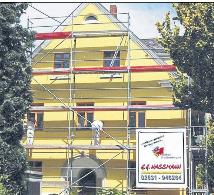
Der Neuwieder Meisterbetrieb sorgt mit fachgerechter Fassadensanierung, Wärmedämmung und individueller Farbgestaltung für Schutz, Werterhalt und ein ansprechendes Erscheinungsbild. Foto: G.G. Wassmann
