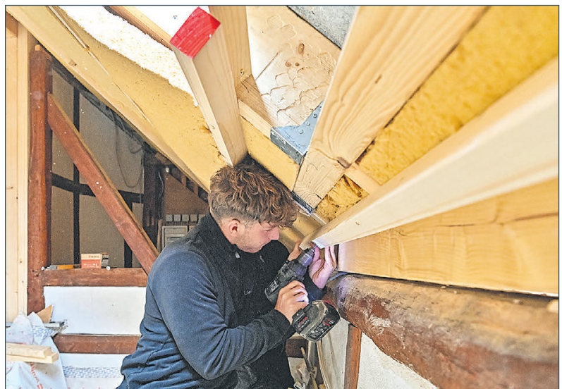
In einem kleinen Häuschen in Herringen vom Anfang des 20. Jahrhunderts hat die Zimmerei das Fachwerk-Eichenholz ausgebaut, die Gefache aufgemauert, das Dach abgerissen, ein neues errichtet. Jetzt wird der neue Dachstuhl von innen gedämmt. Fotos: Schmalenbach
