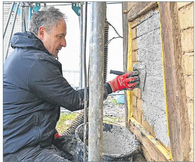
Schulleiter Stefan Laux erledigt Restarbeiten. Deutlich ist zu erkennen, wie sich der Vorspritzmörtel über die Lehmziegel legt.
