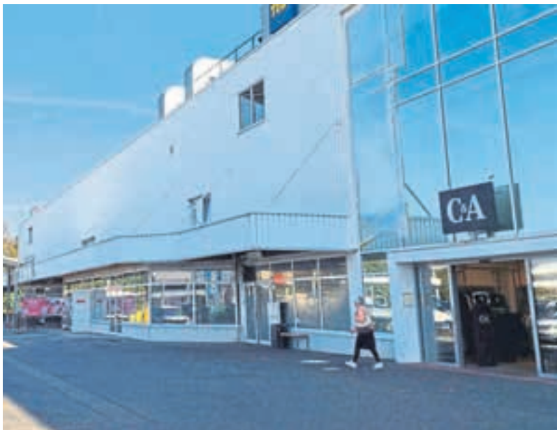
Hier entsteht die neue Kaufland-Filiale.
