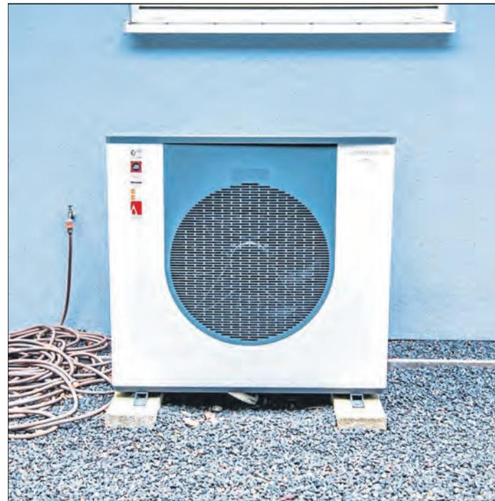
Laub, Staub, Spinnenweben und Vogelfedern können die Leistung von Wärmepumpen beeinträchtigen und die Lebensdauer reduzieren.
