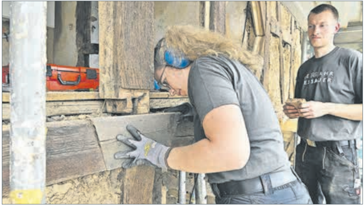
Lehrerin Simone Strefler beim Aufbohlen: Holzbalken werden Stück für Stück wieder „zusammengepuzzelt“.
