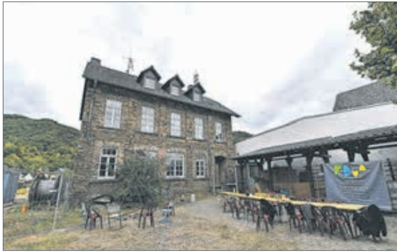
Die alte Schule ist ebenfalls ein Fluthaus – und temporäre Herberge.
