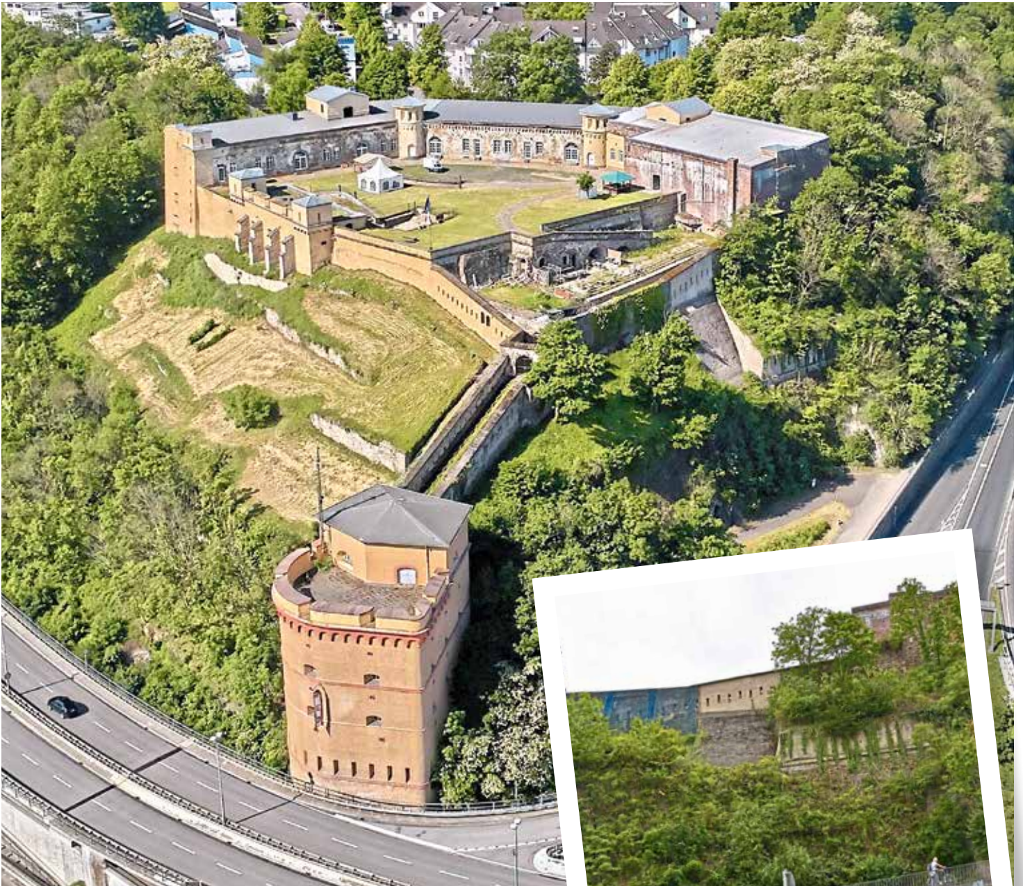
Luftbild (Stadt Koblenz/Olaf Schepers): Ab Montag entfernen Kletterer den Bewuchs am Nordhang unterhalb von Fort Konstantin und oberhalb der Simmerner Straße.
