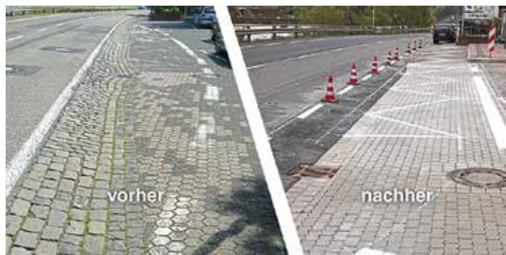
Vorher-Nachher-Vergleich der Zufahrt zum Mostertplatz in Lay.
