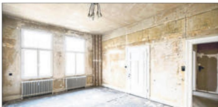
Unebene Wände und sichtbare Installationsleitungen sind bei der Altbausanierung eine Herausforderung. Gipsplatten sind eine schnelle Lösung, um die Innenräume zu modernisieren.
