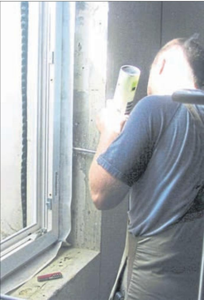
Montageschaum reicht beim Einbau neuer Fenster nicht aus – der Rahmen muss luftdicht in der Leibung verklebt werden.
