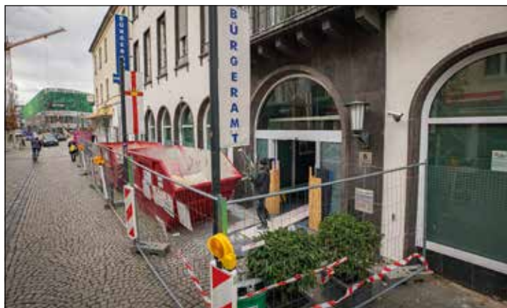
Der bisherige Standort des Koblenzer Bürgeramtes in der Gymnasialstraße wird derzeit umgebaut. Foto: Stadt Koblenz/Andreas Egenolf
