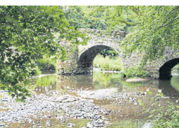
Die historische Nisterbrücke westlich des Klosters Marienstatt. Foto: Schlechtriem
