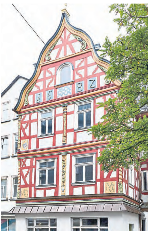
Das sanierte Fachwerkhaus am Kleinen Markt hat eine besonders reich geschmückte Fassade. Ein echter Hingucker. Foto: Stadt Montabaur/Olaf Nitz
