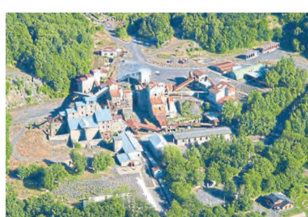
Der Stöffel-Park ist ein riesiger Abenteuerspielplatz und ein lebendiges Museum zugleich. Foto: Stöffel-Park
