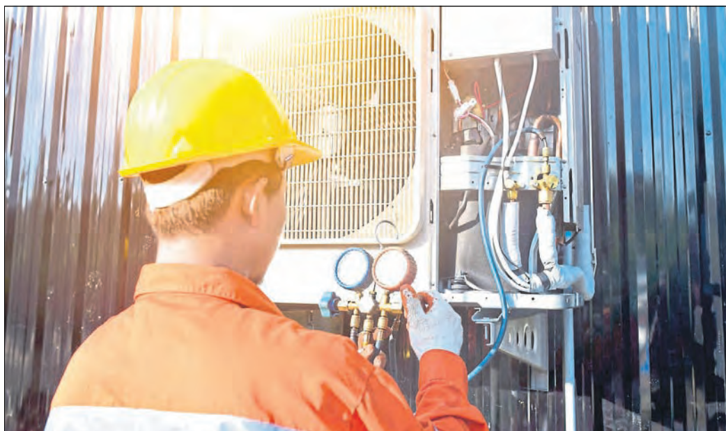
Die Firma HERO aus Bendorf überzeugt als kompetenter Ansprechpartner rund um die Haustechnik mit hochwertiger Arbeit. Foto: HERO
