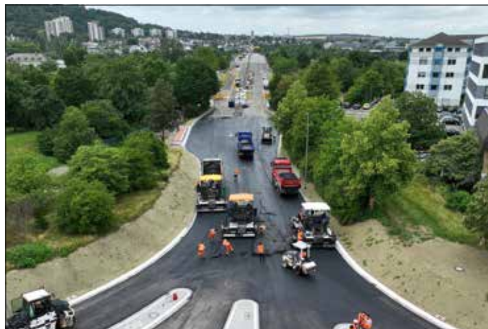
Am 3. Juli 2023 befanden sich drei Fertiger und vier Walzen auf der Baustelle im Einsatz. Foto: Eurovia Bau GmbH/ Amr Azab
