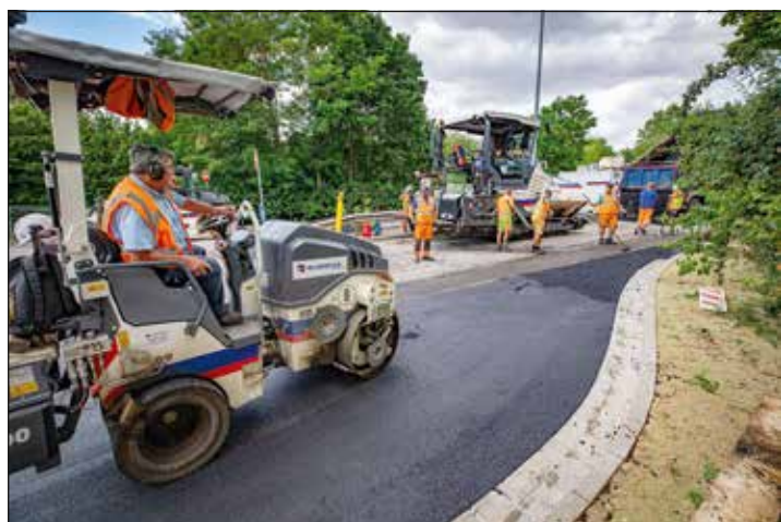
Einbau der Asphaltdecke für den ersten Bauabschnitt des neuen Kreisverkehrs an der Kurt-Schumacher-Brücke am 3. Juli 2023. Foto: Stadt Koblenz/ Andreas Egenolf
