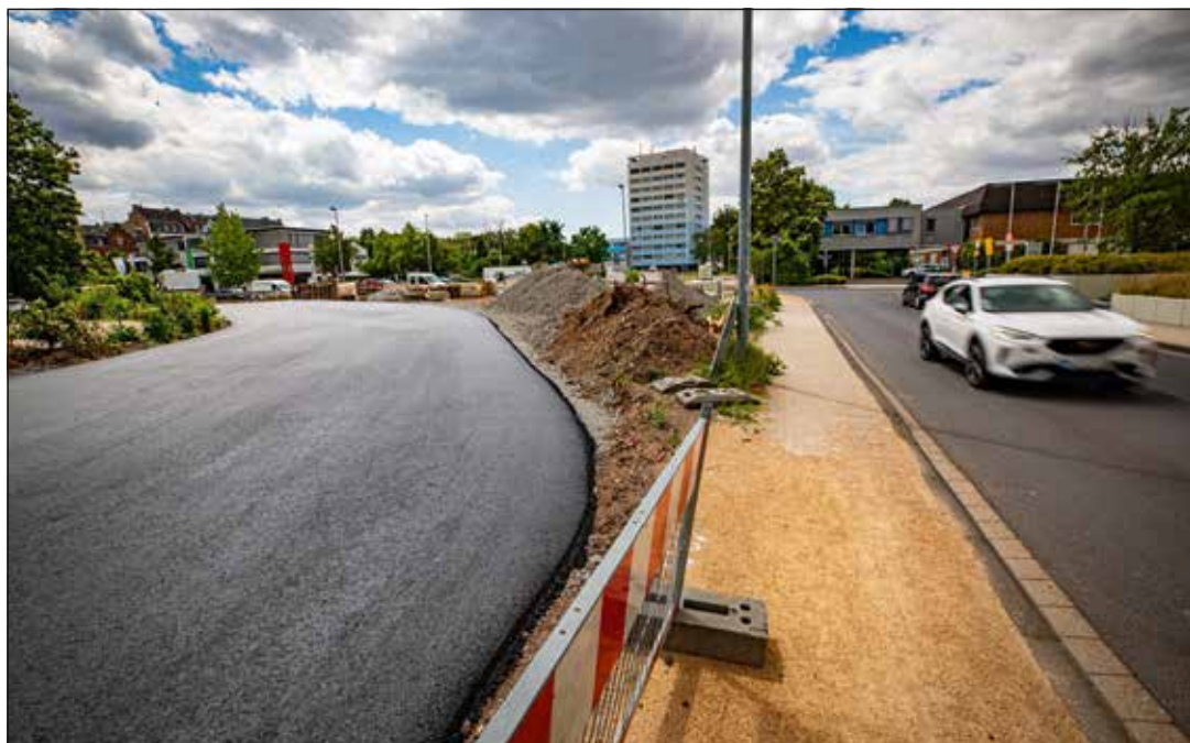
Die provisorische Umfahrung von der südlichen Ferdinand-Sauerbruch-Straße über den ehemaligen Schotterparkplatz wurde hergestellt. Foto: Stadt Koblenz/ Andreas Egenolf
