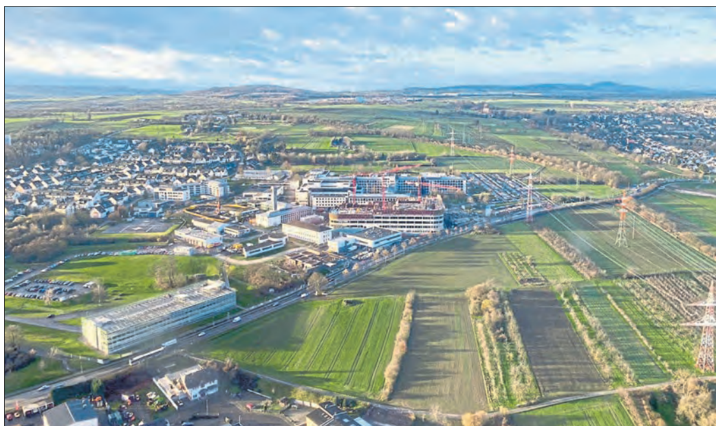
Es ist schon ein beeindruckender Komplex, den das BWZK in Metternich einnimmt.
