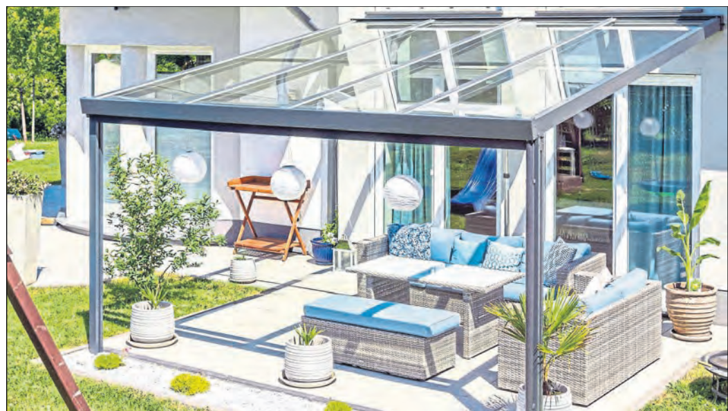
Die hochwertige Bedachung bietet einen soliden Witterungsschutz.
