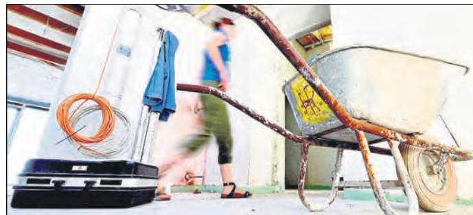
Baustellenfotos sind praktisch, gerade Detailaufnahmen sowie die genaue Position von Leitungen und Rohren.
